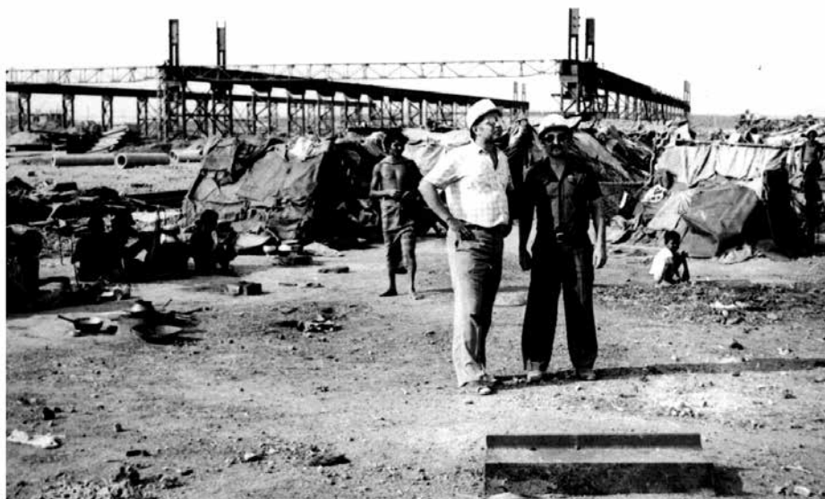
Строительство металлургического завода в Вишакхапатнаме
