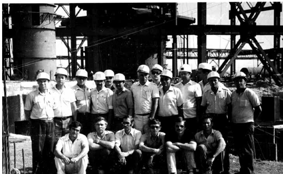
На строительстве завода в Дургапуре
