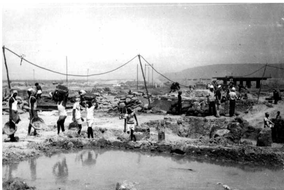
Строительство металлургического завода в Вишакхапатнаме
