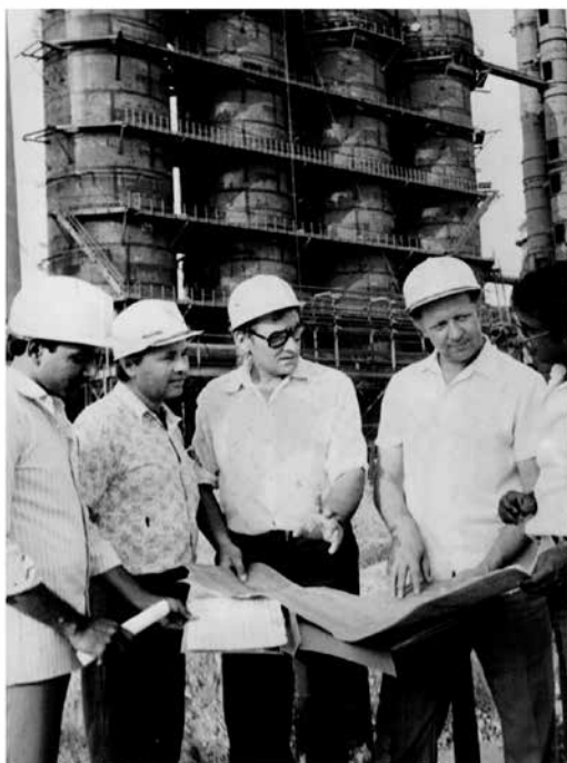
Строительство металлургического завода в Вишакхапатнаме
