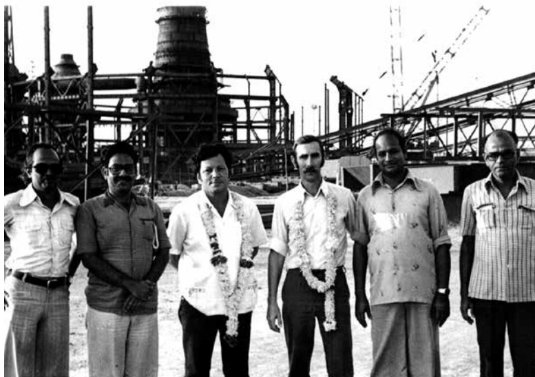
На строительстве завода в Дургапуре
