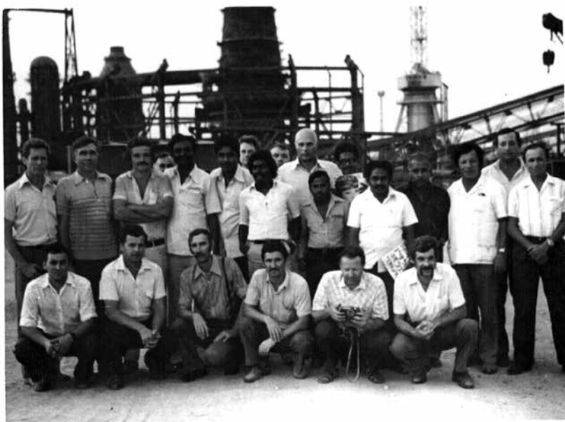
На строительстве завода в Дургапуре
