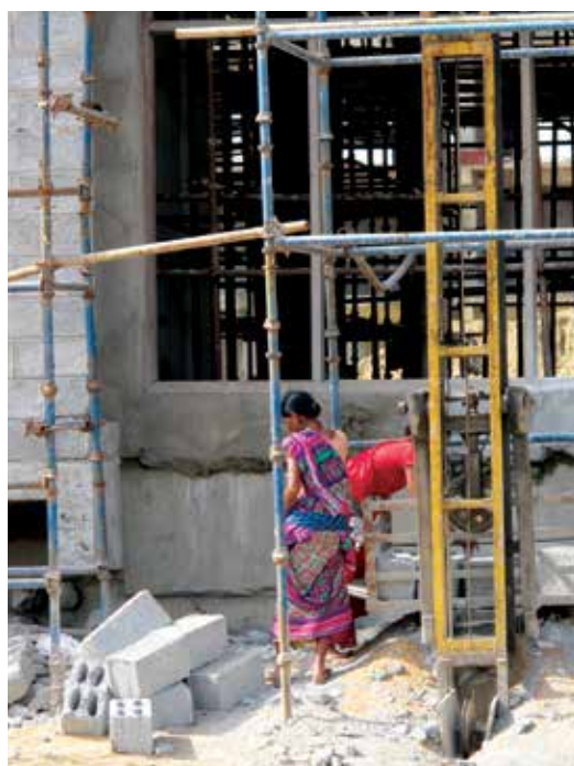
Погрузка блоков в подъемник
