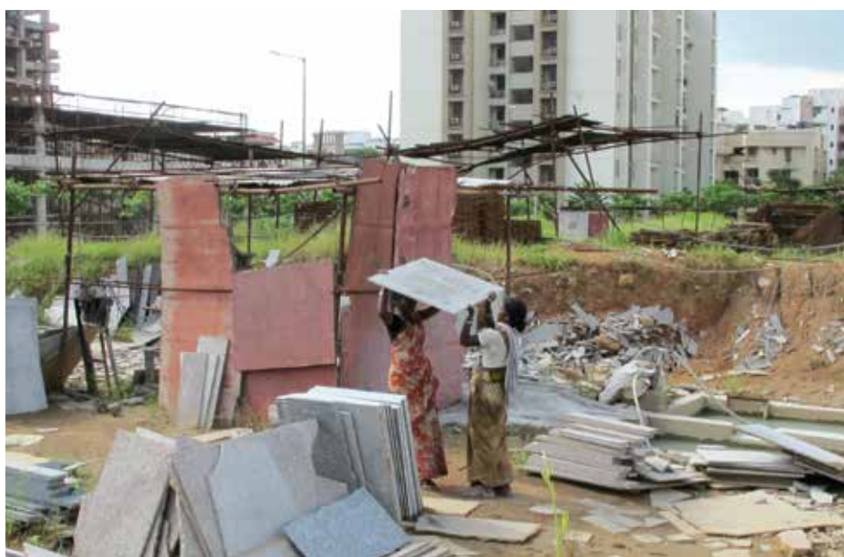
Резка мраморных плит. Вынос готовых плит. Подъем плиты на голову
