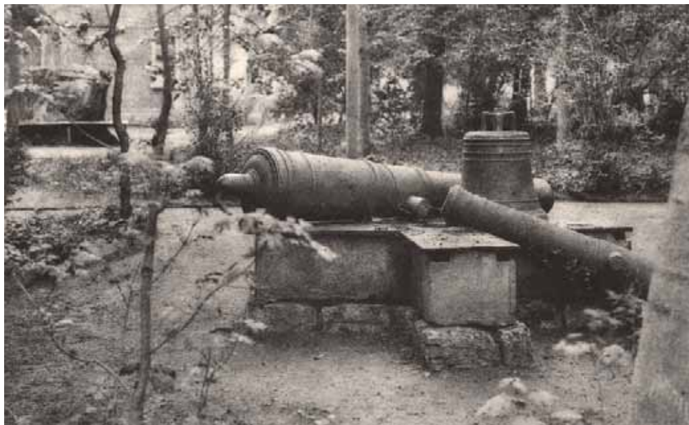
Пушки и колокол, отлитые на Липецких заводах. Фото начала XX в.
