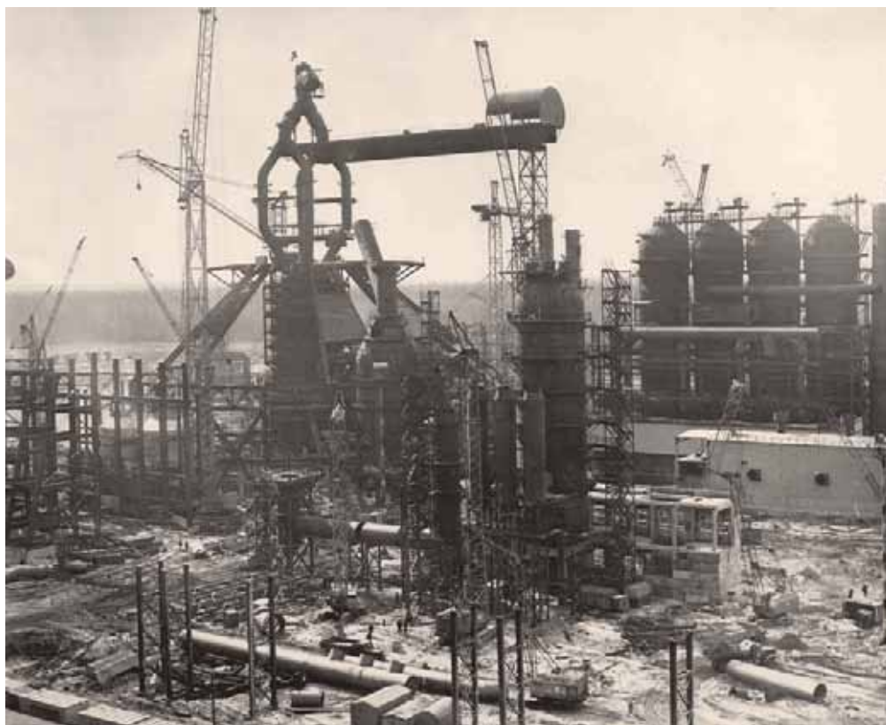
Строительство доменной печи № 6 НЛМЗ. Фото 1978 г.
