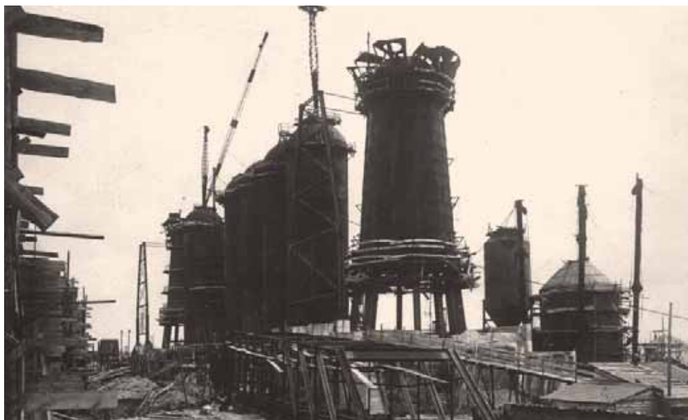
Строительство доменной печи НЛМЗ. Фото 1933 г.
